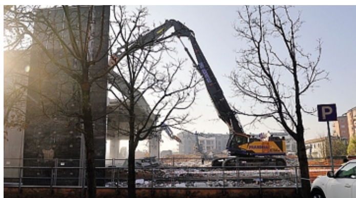
Alle battute finali gli abbattimenti degli edifici all'ex Consorzio agrario
